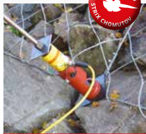
Trhací zkouška injektované kotvy
