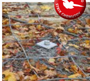
Detaily spojů lan tvořených dvěma páry drátů
